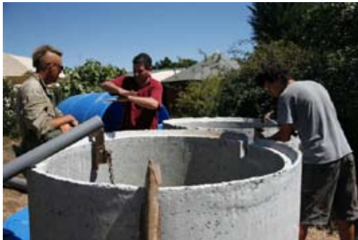
tanque externo de betão
