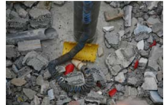
pedras na base do tanque
